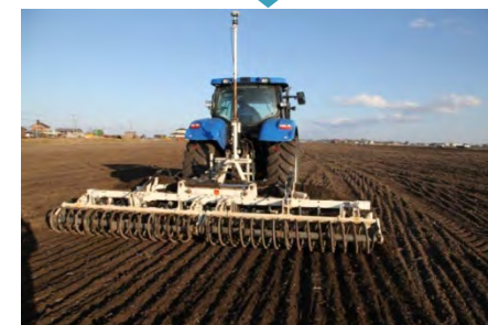
GPSレベラーによる均平
