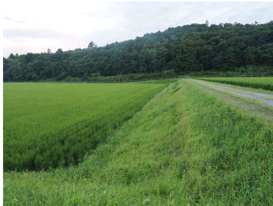
法面高さは3m程度
